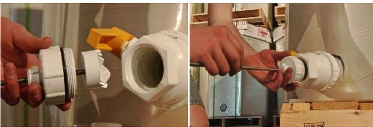
Adjunte el cortador del émbolo directamente a la válvula y gire la manija amarilla a la posición abierta. Una vez que la válvula está abierta usted está listo para perforar la membrana en el revestimiento.
