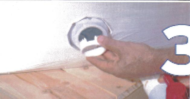
Tome el cortador de anillo desechable y gire el cortador de manera que los dientes estén frente a la membrana. Suavemente vuelva a insertar el cortador en el accesorio de evacuación de 2".
