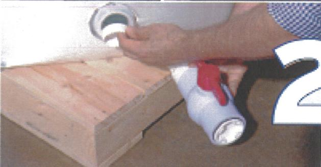
Retire el "cortador de anillo desechable de 2" del accesorio de evacuación. Gire la manija de la válvula de bola a la posición abierta, de modo que el mango de la válvula este alineado con el cuerpo de la válvula. La válvula debe estar en esta posición (ABIERTA) a fin de despejar la esquina de la plataforma durante la instalación.
