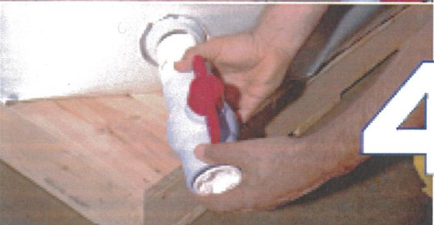
Ensarte el ensamble de la válvula de bola en la parte inferior del accesorio de evacuación. Mientras el conjunto de la válvula está siendo enroscada en su lugar, el aumento del acoplamiento de la rosca hará que el cortador desechable perfora la membrana. NOTA: Es muy importante insertar el conjunto de la válvula hasta el fondo para asegurarse de que la junta tórica está ajustado y sellado contra el accesorio de evacuación.
